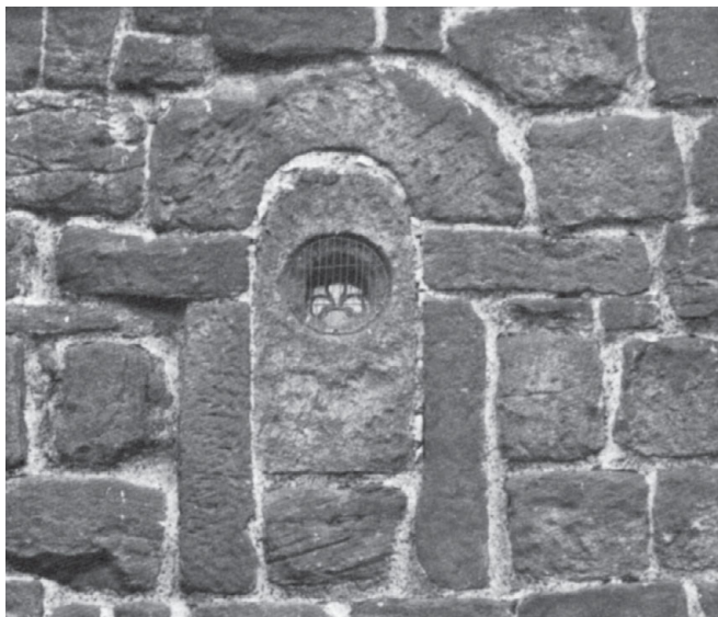
Рис. 4. Церковь в Ярроу, деталь саксонской кладки
